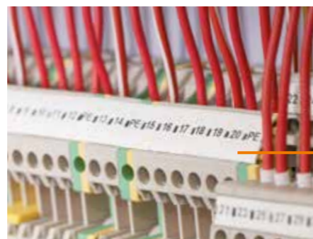
DEK/WS: marcatori per morsetti - stampi, collochi e l'operazione è terminata!
