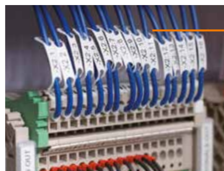
WM: i marcatori per cavi vengono installati senza l'ausilio di utensili - progetta su computer e stampa direttamente su bobina.
